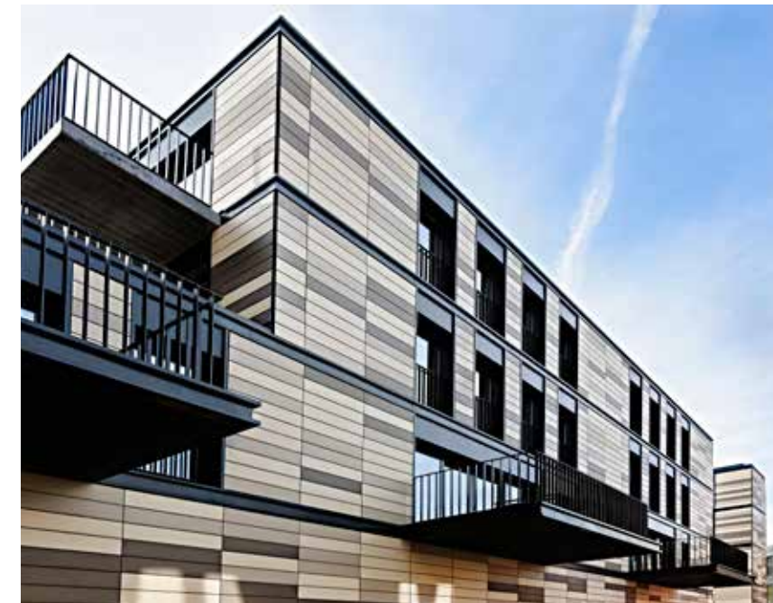
De gevelbekleding bestaat niet uit monochroom metselwerk, maar uit vlakke, keramische platen in drie zandkleurige tinten.
